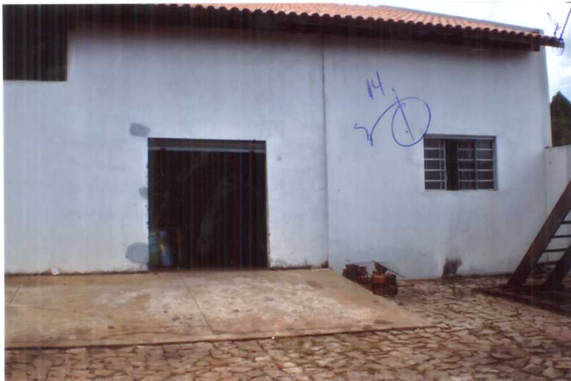
Foto 7 – Acesso ao galpão em rampa e ao lado o caixilho da copa
