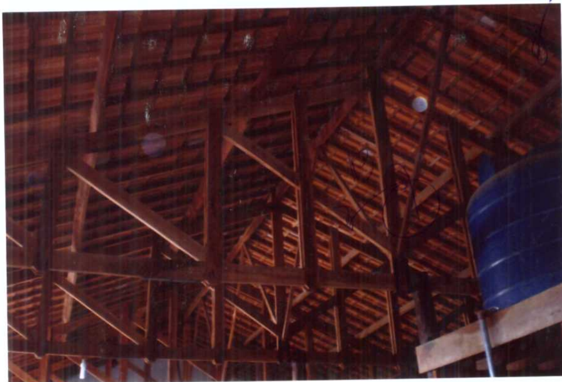
Foto 6 – Detalhe das treliças da estrutura para apoio do telhado
