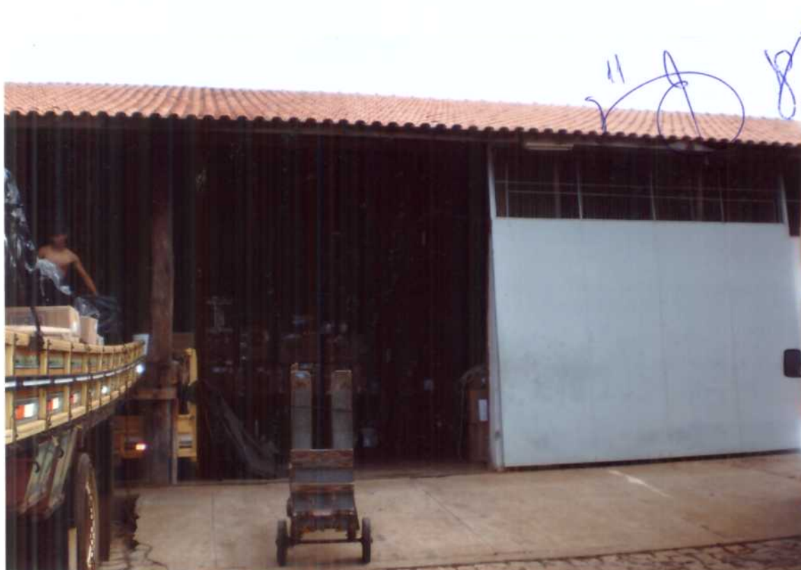
Foto 4 – Vista do galpão estabelecido sobre o lote de nº “5”
